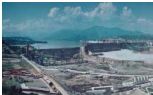
Baugrube des Krafthauses und der Betonmauer, rechte Seite (vom Oberwasser aus gesehen).
