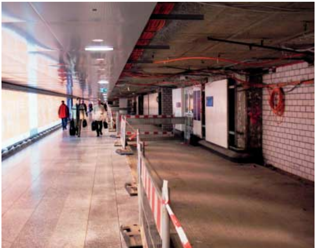
Blick in die mittlerweile zur Hälfte modernisierte Verteilerspange.
