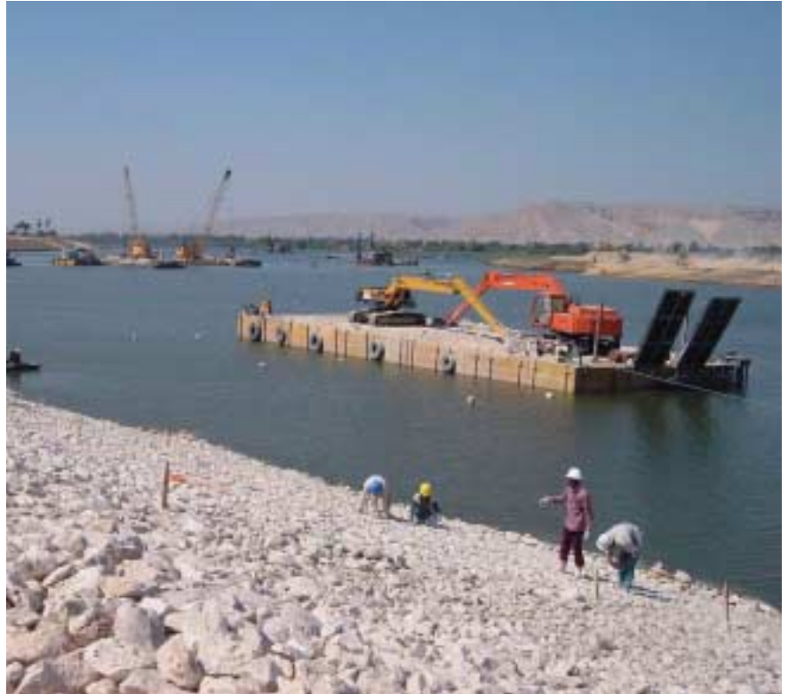
Befestigungsarbeiten am Flussbett des Umleitungskanals.
