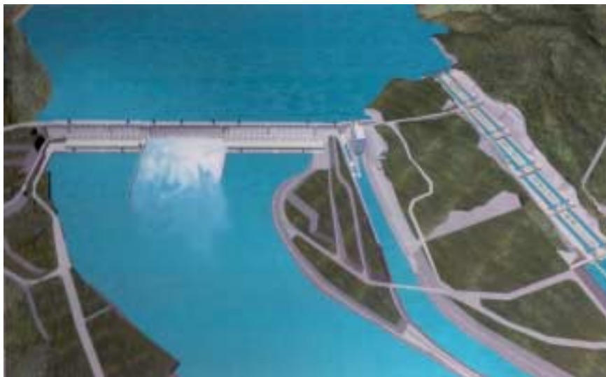
Gesamtansicht des Drei-Schluchten-Projektes. Bauwerke (von der linken zur rechten Talflanke): Schleusentreppe, Schiffshebewerk, Behelfsschleuse für die Bauzeit, Betonmauer und linkes Krafthaus, Hochwasserentlastung, Betonmauer und rechtes Krafthaus.
