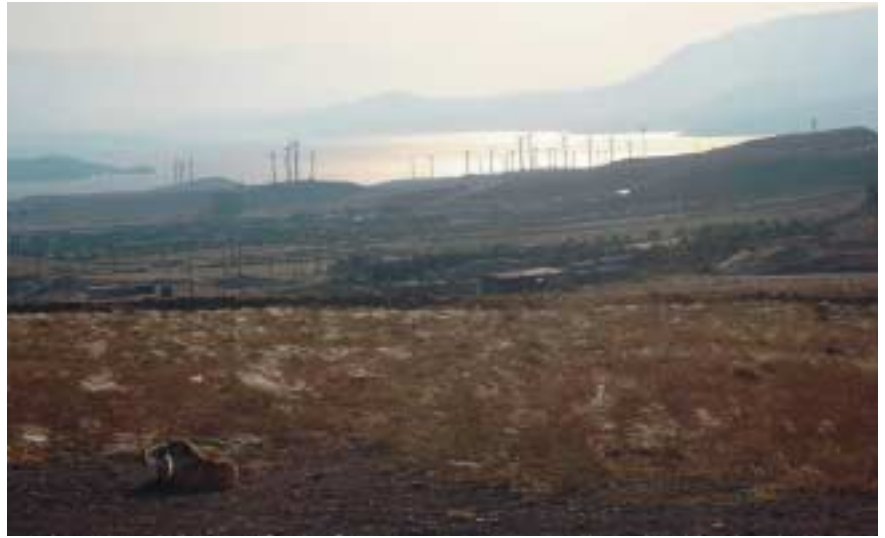
Windpark in Manjil, das ca. 220 km nordöstlich von Teheran in der Provinz Gilan liegt.
